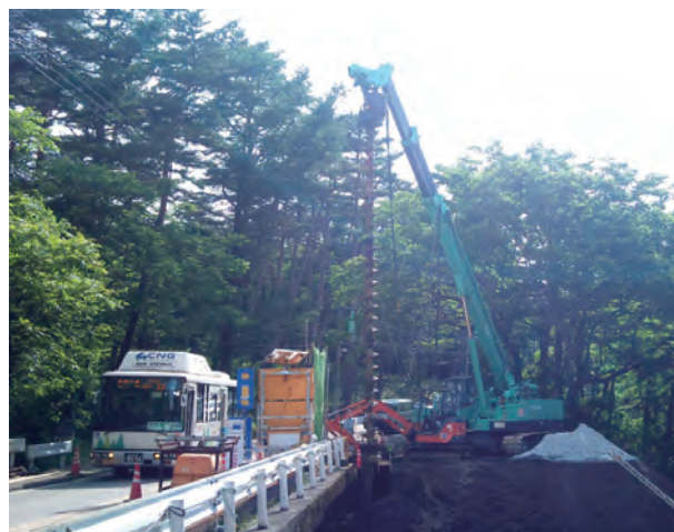
ダウンザホールハンマー工法
