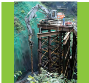
ダウンザホールハンマー工法 仮設構台杭打設
