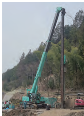
ダウンザホールハンマー工法 ダブルオーガによる連続掘削
