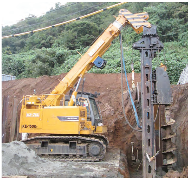
ダウンザホールハンマー工法
