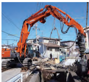
ダウンザホールハンマー工法 上空制限有
