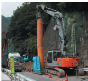
ダウンザホールハンマー工法
