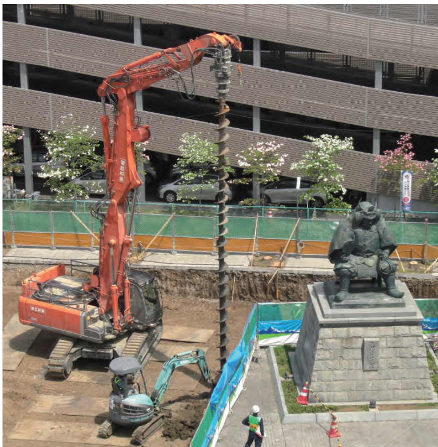
アースオーガ工法 先行掘削
