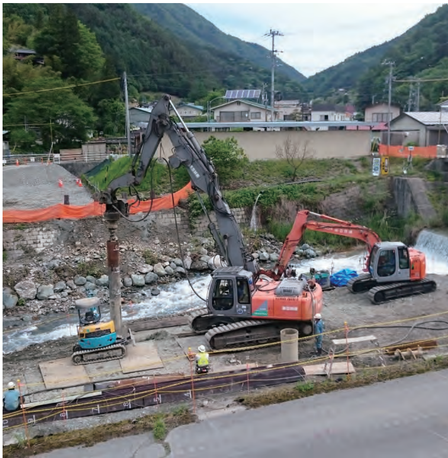
ケーシング連行(二重管式)ダウンザホールハンマー工法 河川内施工
