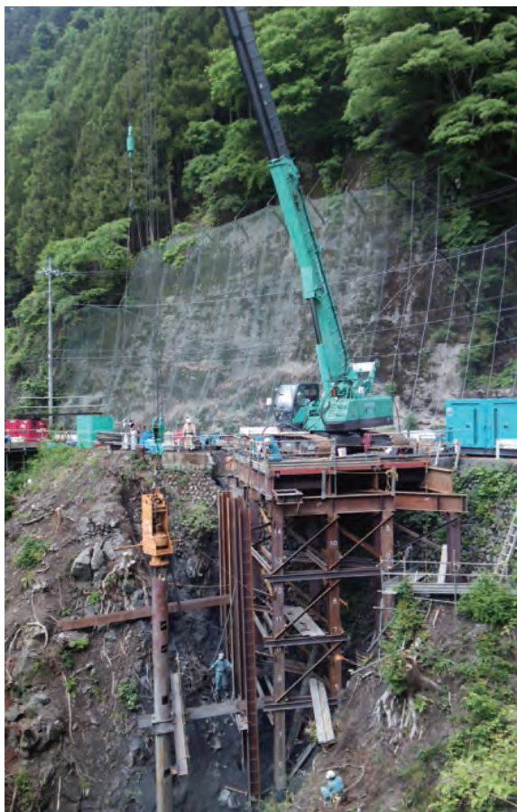
ダウンザホールハンマー工法 吊り下げ式 仮設橋台設置
