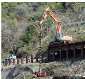
ダウンザホールハンマー工法
