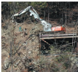
ダウンザホールハンマー工法
