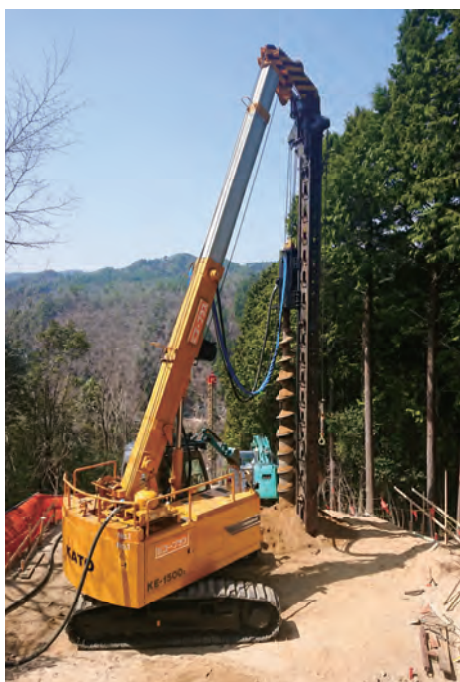
ダウンザホールハンマー工法
