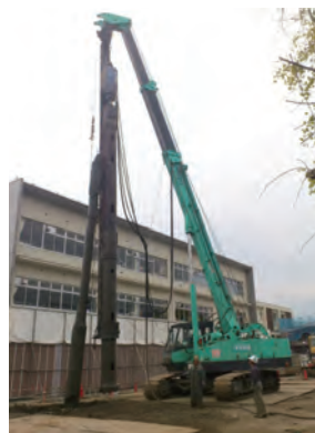
ケーシング工法 既存杭引抜
