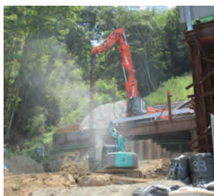
ダウンザホールハンマー工法 鋼矢板打設
