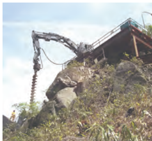
ダウンザホールハンマー工法
