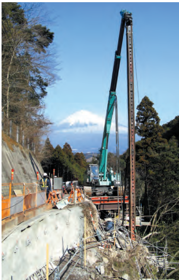
ダウンザホールハンマー工法 橋梁杭管杭打設
