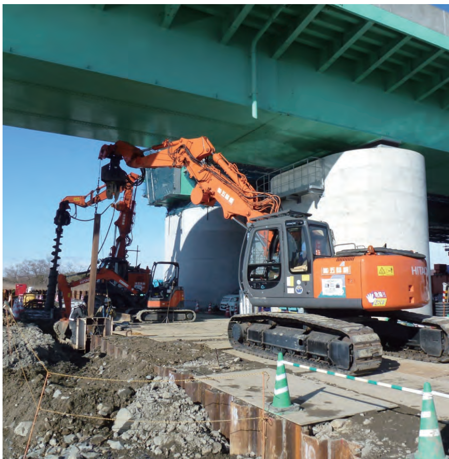
ダウンザホールハンマー工法 鋼矢板打設 上空制限有 継杭施工
