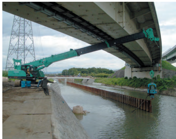
パイプロハンマー工法
