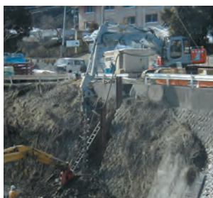
ダウンザホールハンマー工法
