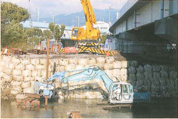
樹木下、河川内施工
