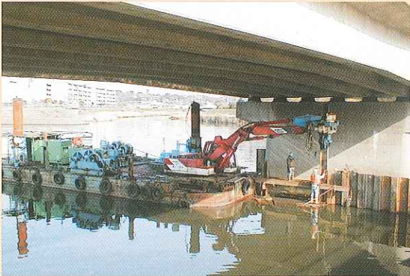
桁下、水上施工
