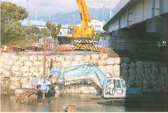
樹木下、河川内施工
