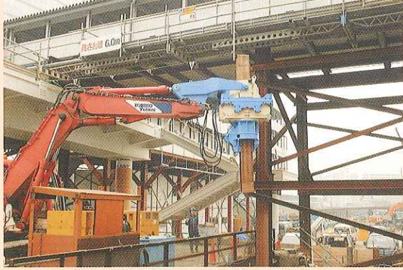
桁下、狭隘地施工
