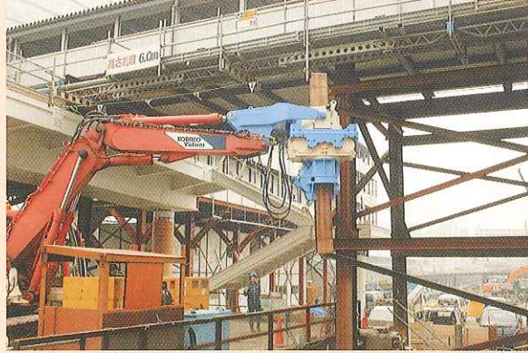
桁下、狭隘地施工
